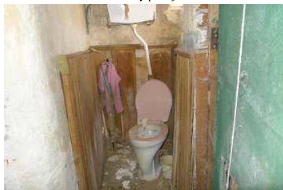
Záchod ve výklenku chodby
