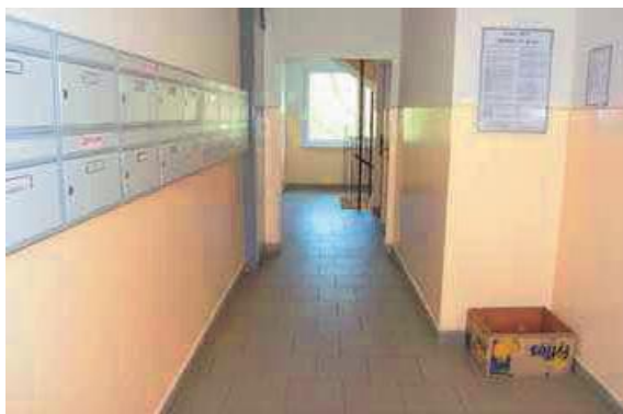
Vstupní chodba v domě
